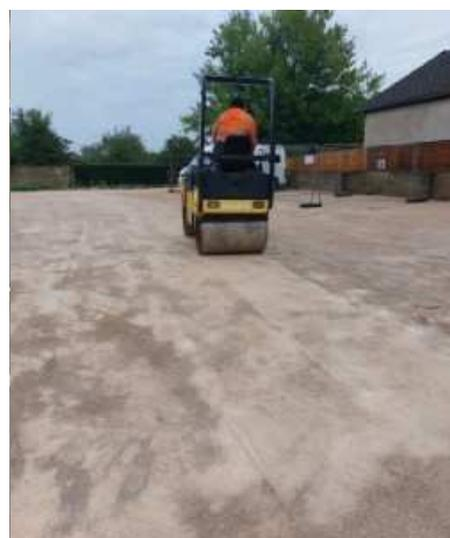
Une couche de concassé a été appliquée par le service technique et un élu. Ce parking est à disposition des riverains du bas de la rue de Dole. Merci à SNCTP pour le transport gratuit des matériaux et Sébastien NOBLOT pour le prêt du compacteur. Coût de l'opération 200 € (location de la mini-pelle).
