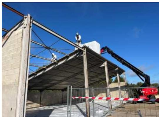
Réalisé par l'entreprise BPTP & Démolitions à Devecey, le désamiantage de la toiture en fibrociment sera suivi par l'agrandissement de la charpente métallique avec l'ajout de deux travées, la couverture par des bacs aciers et la pose de panneaux photovoltaïques. Les fondations de cet agrandissement ont été confiées à FRANCIOLI à Lavans-lès-Dole.
