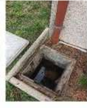
Chéneaux et gouttières
