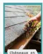
Chéneaux et gouttières
