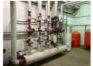
L'alimentation en combustible est régulée en fonction de la demande de chaleur. La distribution de chaleur par eau chaude est identique aux autres installations de chauffage central. L'entretien annuel est réalisé par les fabricants et l'exploitation par l'équipe technique.
