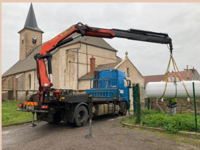
Le système de chauffage du logement du presbytère et de la sacristie n'était plus conforme avec l'actuelle réglementation. Il a été décidé en accord avec la paroisse de ne plus l'utiliser et de procéder au démontage et au retrait de la cuve de gaz qui en assurait son alimentation.
