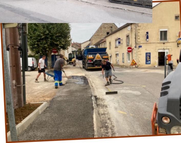
Suite aux travaux d'enfouissement électrique et de branchement d'eau, la pose d'un bicouche a été réalisée à hauteur du trottoir de la rue de la République.
