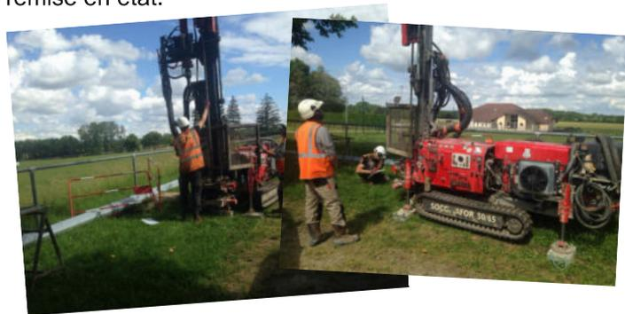
Avant de lancer une consultation, il est nécessaire de connaître la nature précise du sol afin de pouvoir dimensionner les fondations. Ces sondages géotechniques - réalisés le 8 juin - sont donc la 1<sup>ère</sup> étape dans la reconstruction de l'éclairage des terrains de foot.
